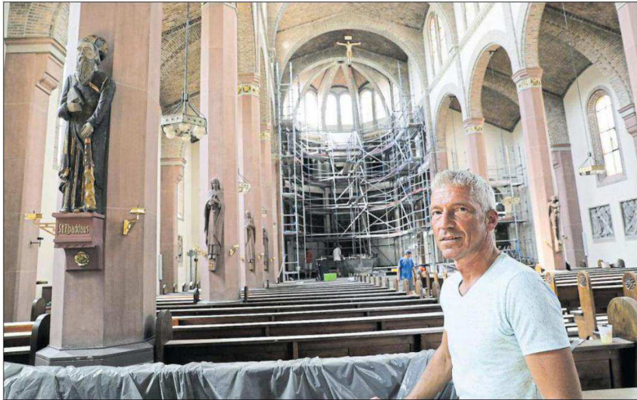
NOCH NICHT GANZ FREI VON GERÜSTEN ist die Bulacher Kirche St. Cyriakus und St. Laurentius. Pfarrer Thomas Ehret wird dennoch ab sofort die Sonntagsgottesdienste wieder in der Kirche zelebrieren. Wochentags sind noch die Restaurateure am Werk. Fotos: jodo
